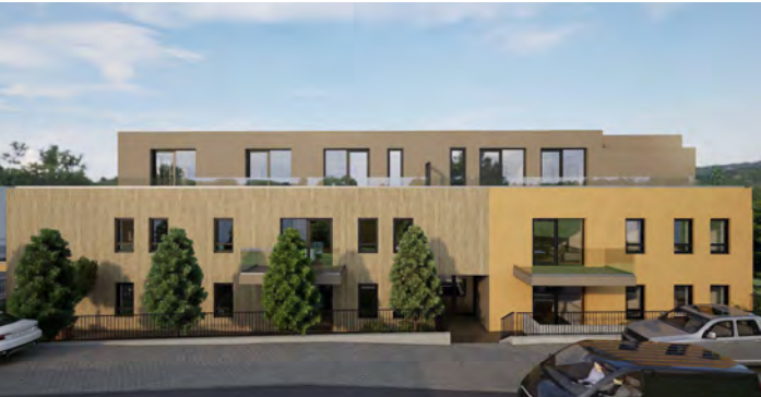
Süd Fassade H1 - Fichtenstraße 14
