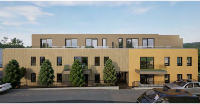
Süd Fassade H1 - Fichtenstraße 14
