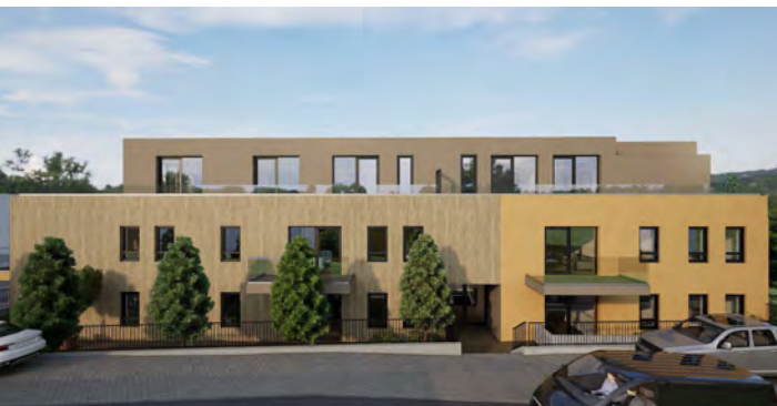
Süd Fassade H1 - Fichtenstraße 14
